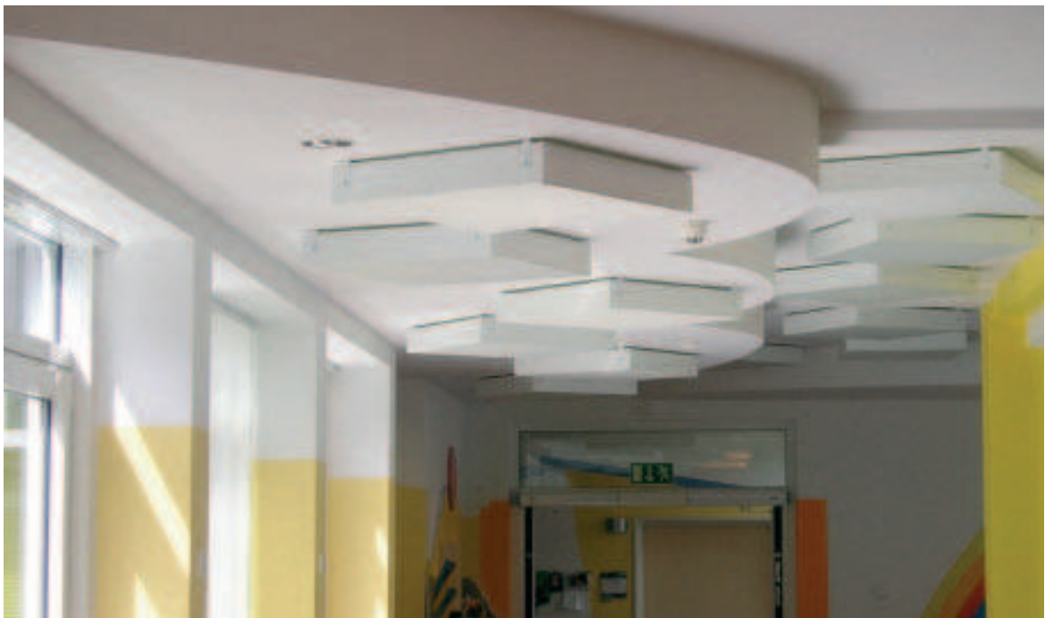
Bild 1: Beispiel eines Schallabsorbers in Verbindung mit Glasgewebe
